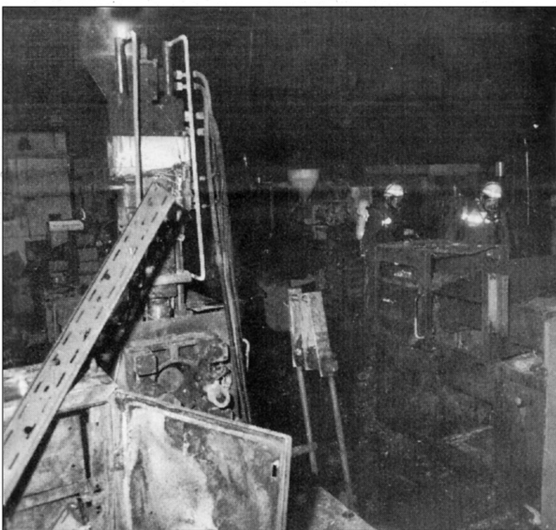
Rußgeschwärzt die Fertigungshalle von Gröner in Bolheim: Feuerwehrleute prüfen, ob noch versteckte Glutnester zu löschen sind.
