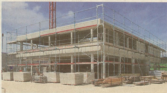
Der Rohbau des EOS-Gebäudes nimmt Gestalt an
