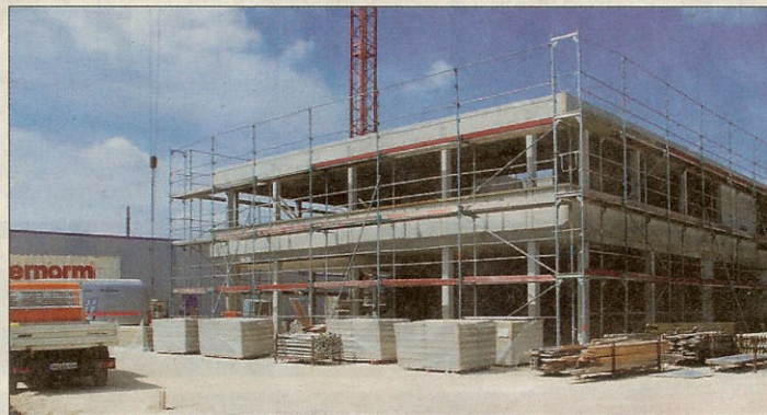
Neuer EOS-Firmensitz: Der Rohbau ist fertig.
